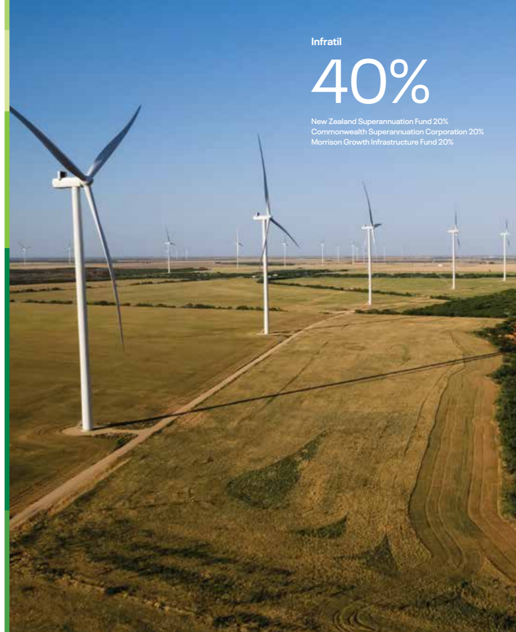
The 243MW El Campo wind farm, Texas
